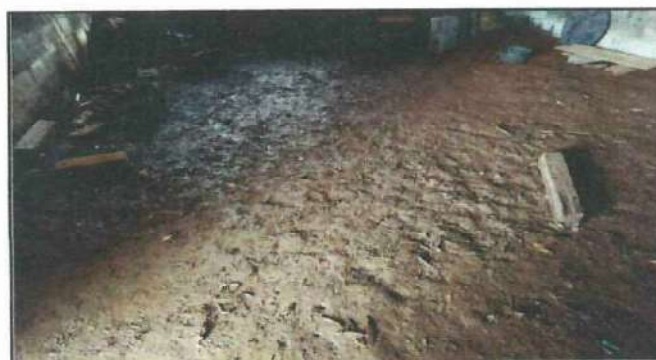
Foto 4: Colocación del piso de torta de cemento.
