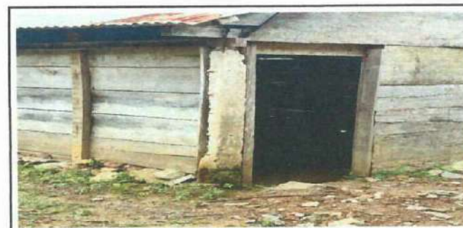
Foto 6: Colocación de puertas y ventanas
