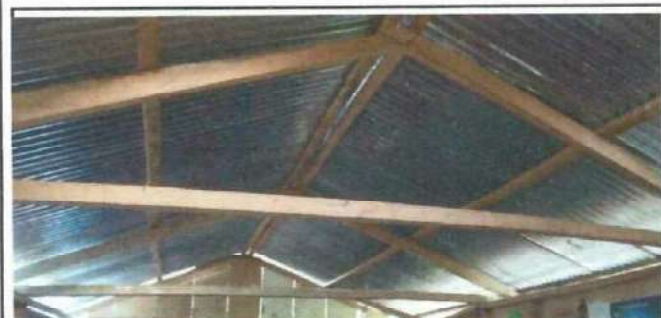
Foto 5: Sustitución de la estructura metálica del techo.
