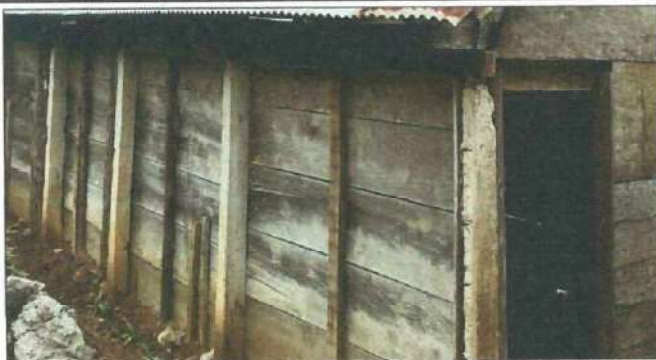
Foto 2: Mantenimiento de columnas de concreto.
