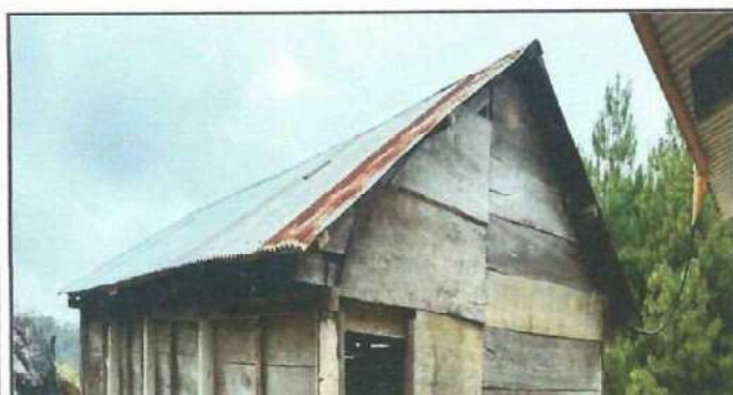
Foto 3: Sustitución de cubierto de lamina.
